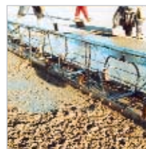
Rütteln, Glätten und Abstreichen in einem Arbeitsgang
